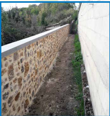
Sentier des bas griptains Réfection du mur de soutènement
