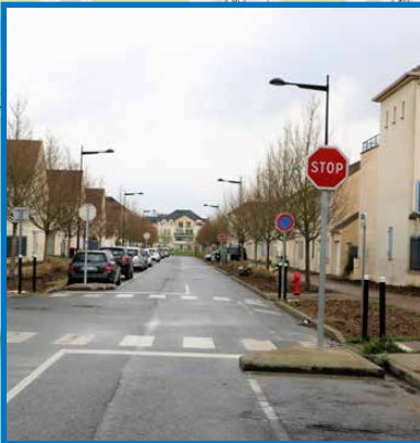
Rue du Triton Crête Pose de panneaux "stop" afin de limiter les vitesses excessives
