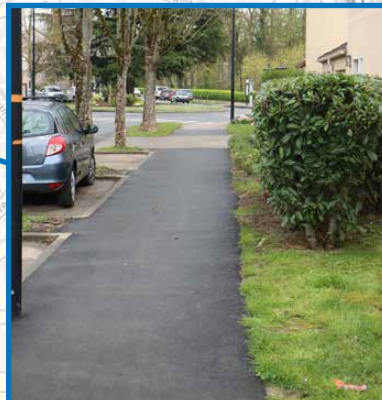
Avenue des Jasmins Réfection de l'enrobé des trottoirs
