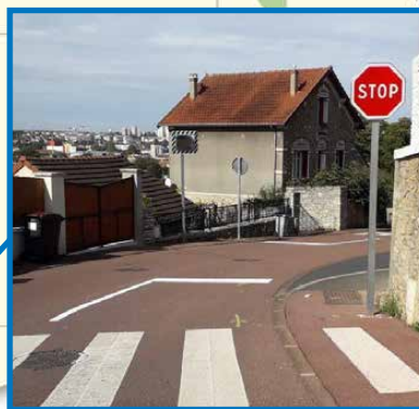
Rue de la Montagne du Perray Pose de panneaux "stop" afin de limiter les vitesses excessives
